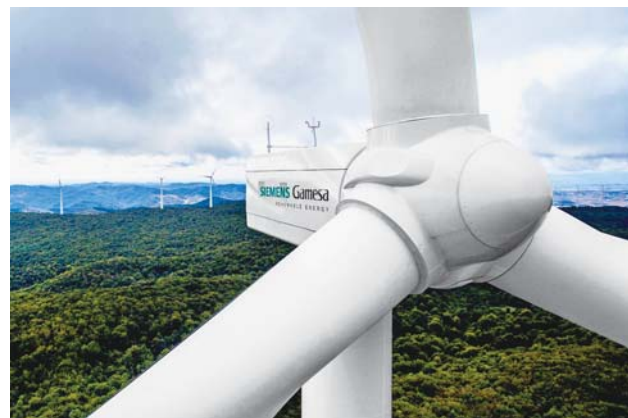
Фото 6. ЛЭЗ ведет разработку ветрогенераторов для компании Siemens Gamesa
