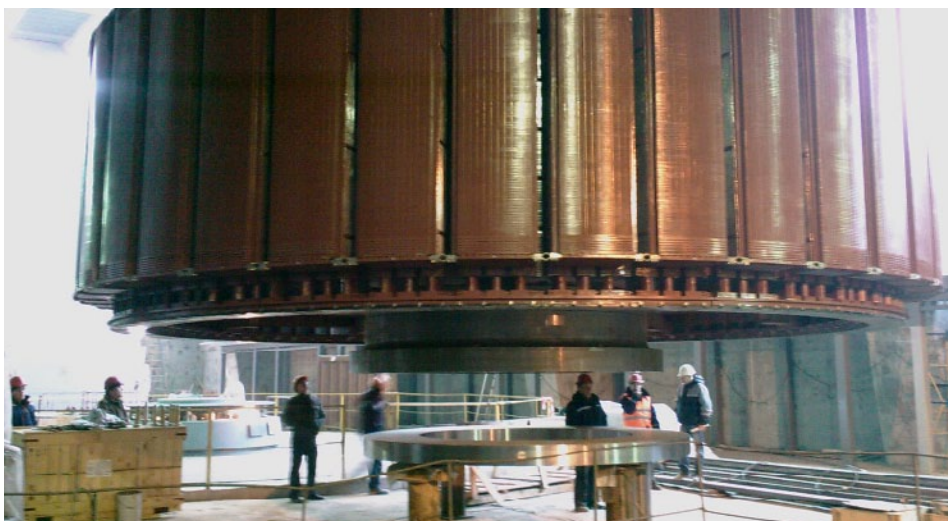
Полюсы ротора опускаются для монтажа остова ротора гидрогенератора
