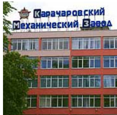
«КМЗ»: здесь производятся лифты «Протон»
